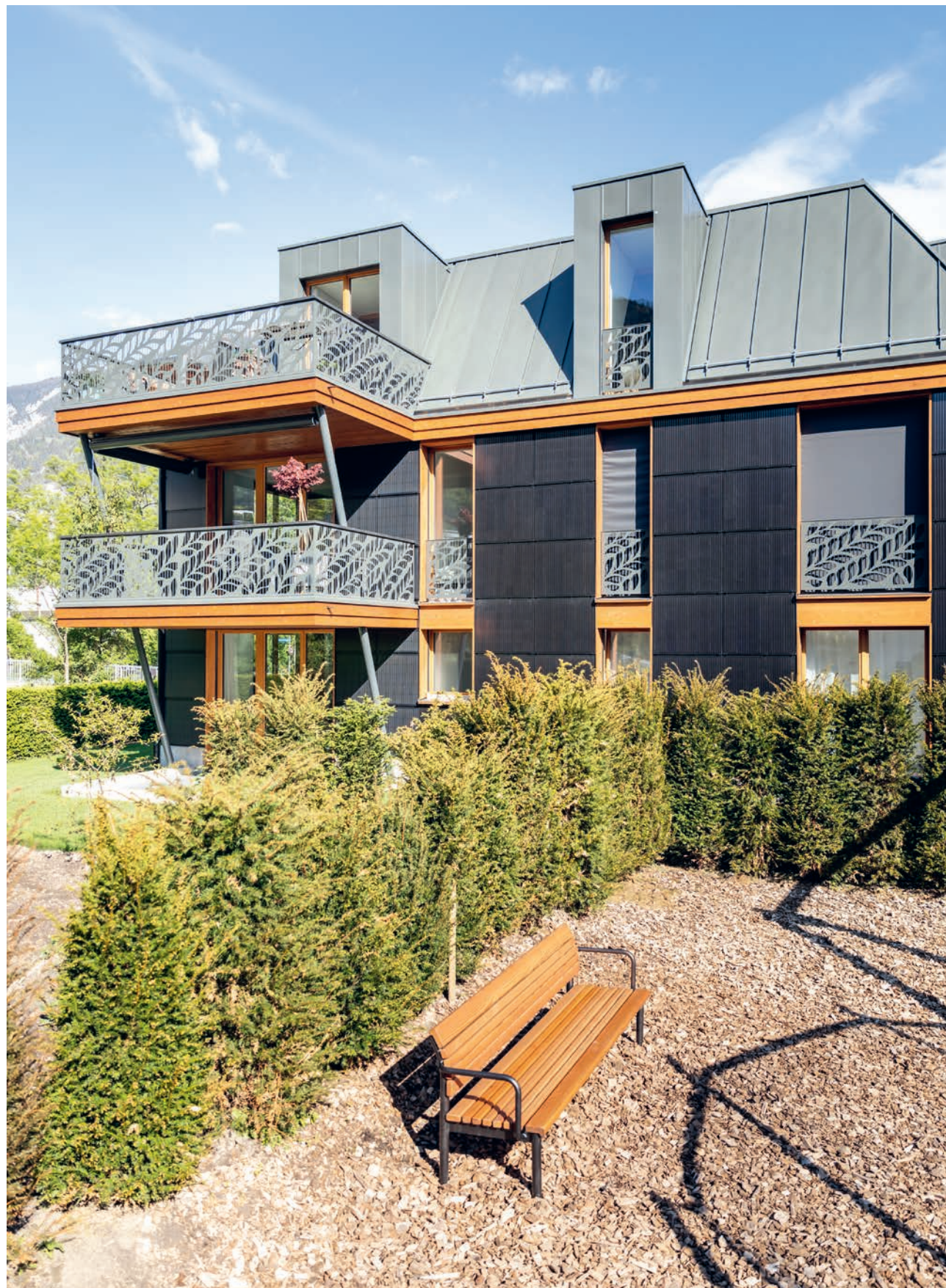
Die Beschattung durch die Balkone musste berücksichtigt werden.
