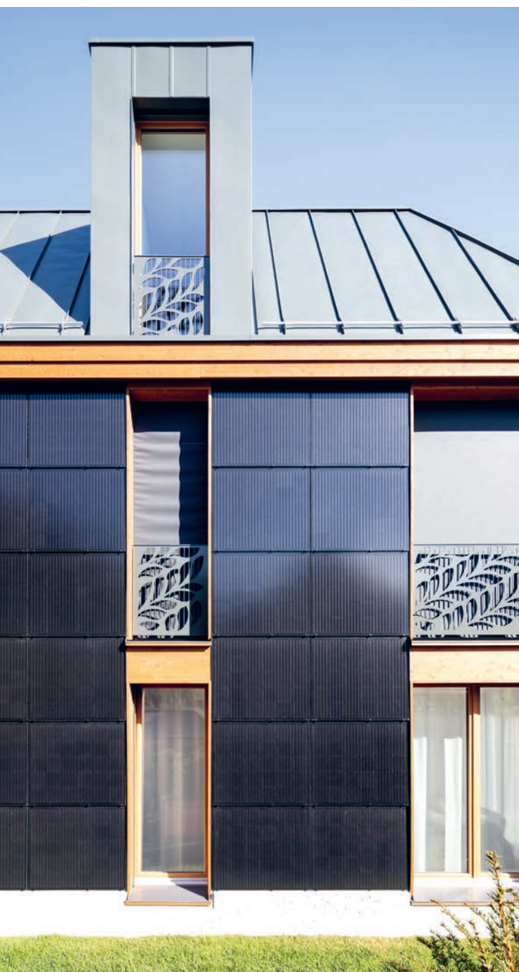
Fenster und Lukarnen harmonisieren perfekt.
